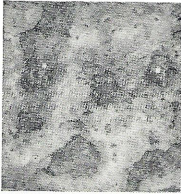
Fig. 26. Proefplaat in middencompartiment van tank No. 5 (top) na 12 maanden. Compartment gebezigd voor ballastdoeleinden. Zware roesthuid met vorming van een ruw ongelijkmatig oppervlak.
